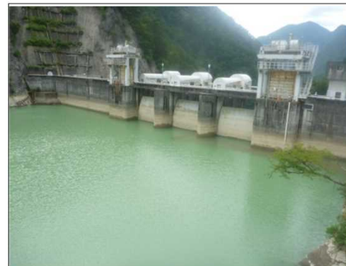
【出し平ダム状況】排砂ゲート開操作時(EL.336.48m) 9月1日 14:00撮影
