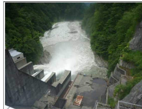
【出し平ダム下流】排砂ゲート開操作時(EL.336.48m) 9月1日 14:00撮影
