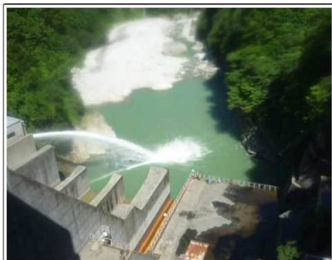
【出し平ダム下流】水位低下開始時(EL.337.21m) 9月1日 10:00撮影
