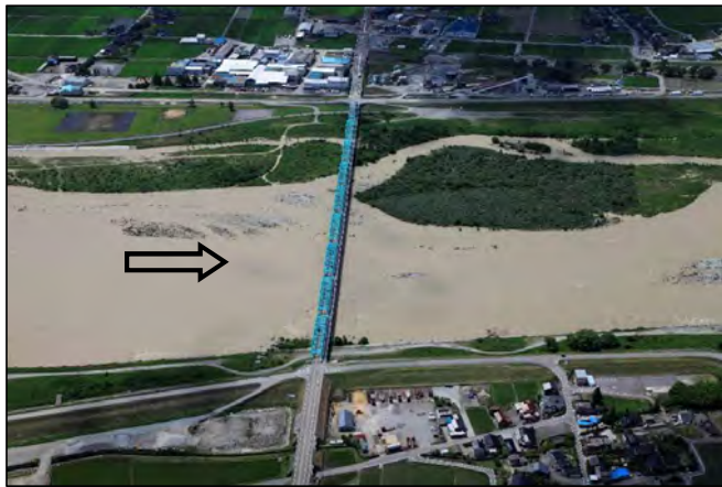
黒部大橋(国道8号)（河口より4.8km）
