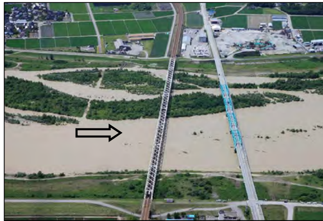
下黒部橋（河口より0.8km）
