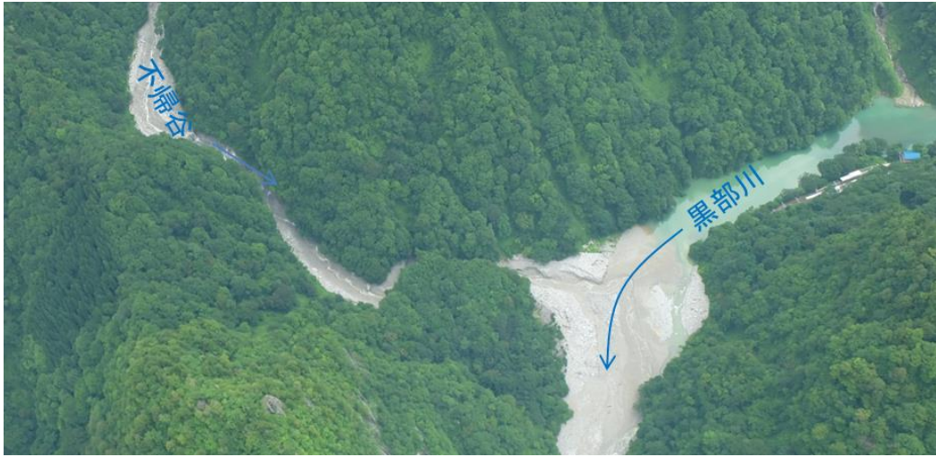
不帰谷からの土砂流入状況（平成 28 年 7 月 14 日）
