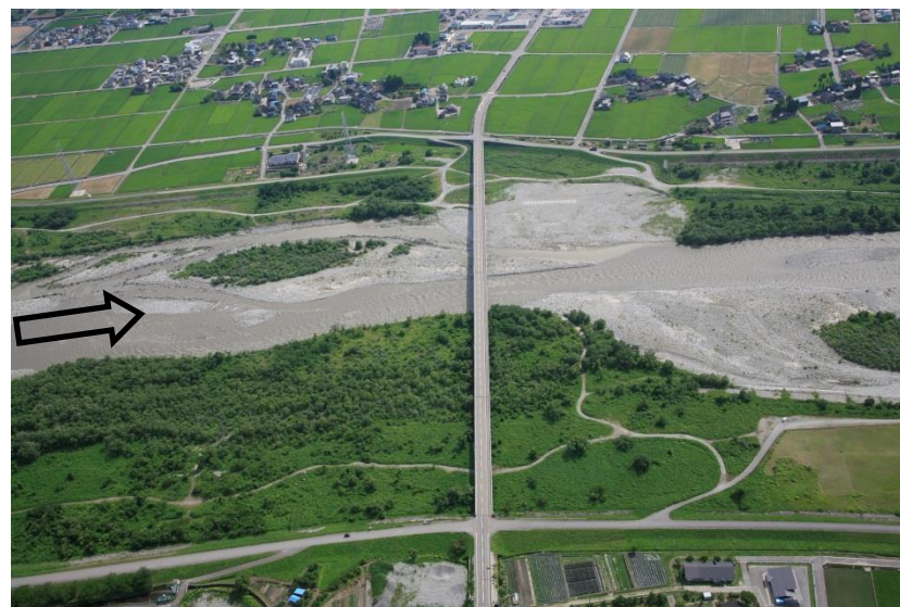
新川黒部橋（河口より9.6km）
