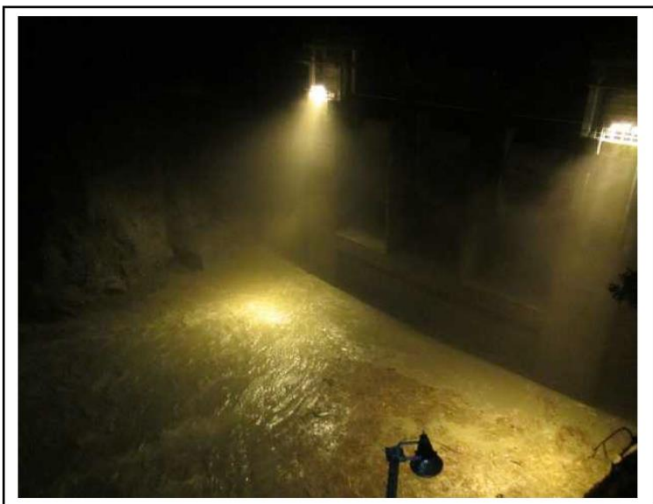
【出し平ダム排砂路呑み口部】 0:10 水位低下中 貯水位:EL309m付近
