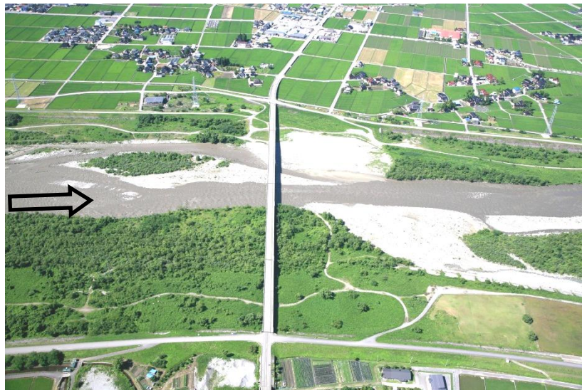
新川黒部橋（河口より9.6km）
