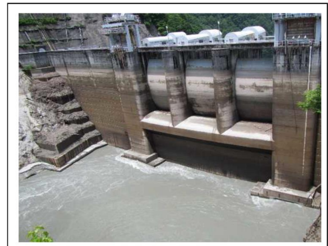
【出し平ダム排砂路呑み口部】 11:40 水位回復中 貯水位:EL306m以下
