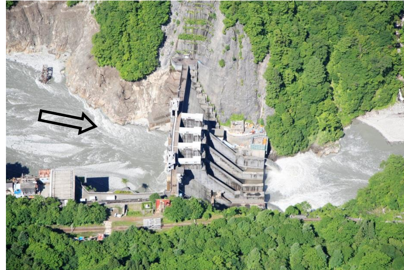
出し平ダム（右岸より望む）
