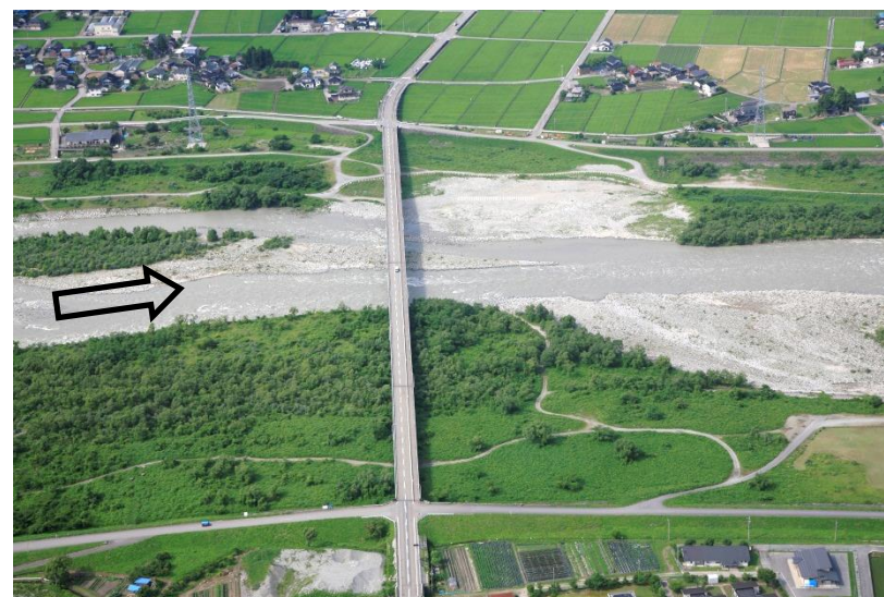
新川黒部橋（河口より9.6km）
