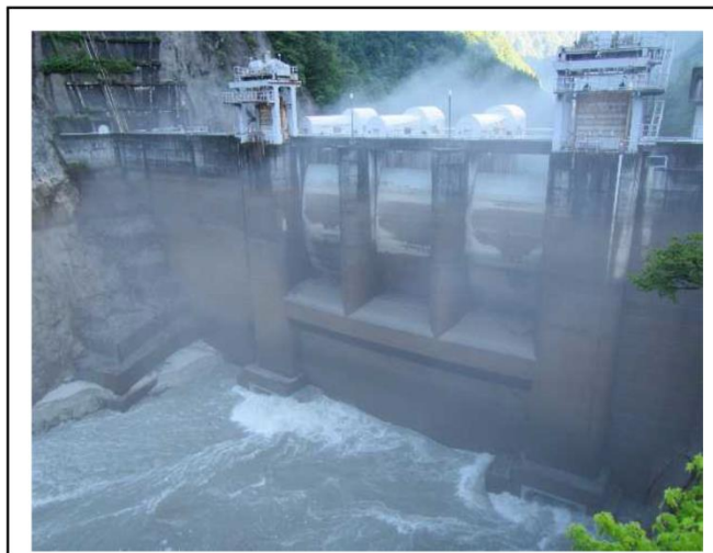
【出し平ダム排砂路呑み口部】 6:00 自然流下中 貯水位:EL306m付近
