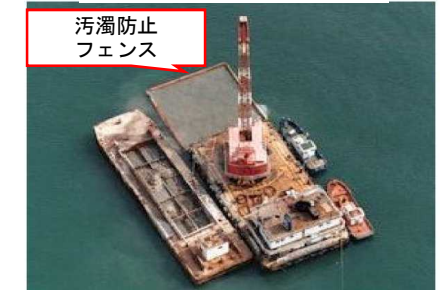
汚濁防止フェンス施工(例)
