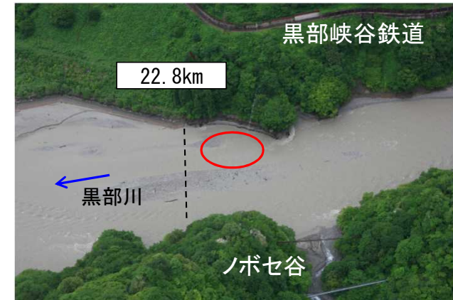
浚渫位置 (平成25年度連携排砂時の空中写真より)
