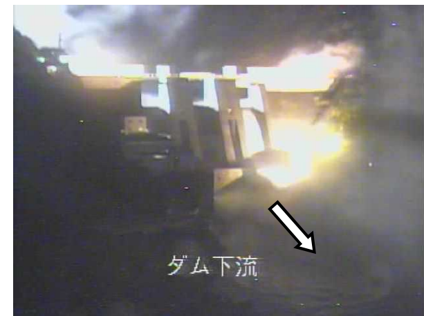
宇奈月ダム直下流（下流より望む） 8/30 20:00
