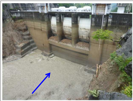
出し平ダム排砂路呑み口部(11時50分頃 自然流下中)
