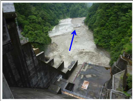
出し平ダム排砂路呑み口部(11時50分頃 自然流下中)
