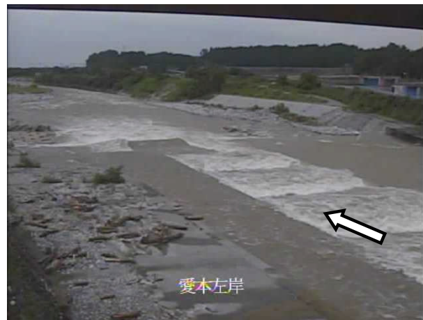
愛本橋下流（上流左岸より望む） 7/28 9:00
