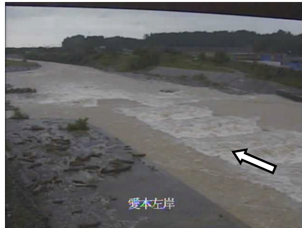
愛本橋下流（上流左岸より望む） 7/28 16:00
