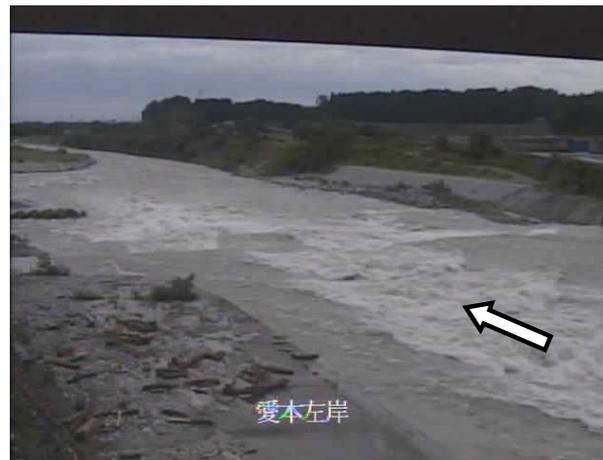
7月8日（出し平ダム：排砂ゲート開、宇奈月ダム：水位低下用ゲート開）
