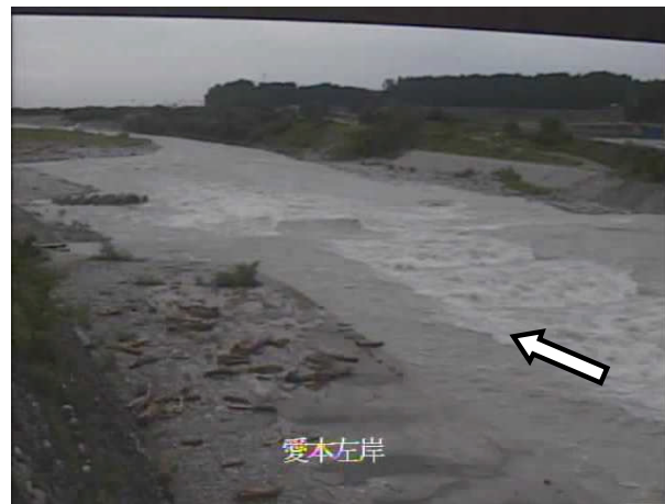
愛本橋下流（上流左岸より望む） 6/28 10:00
