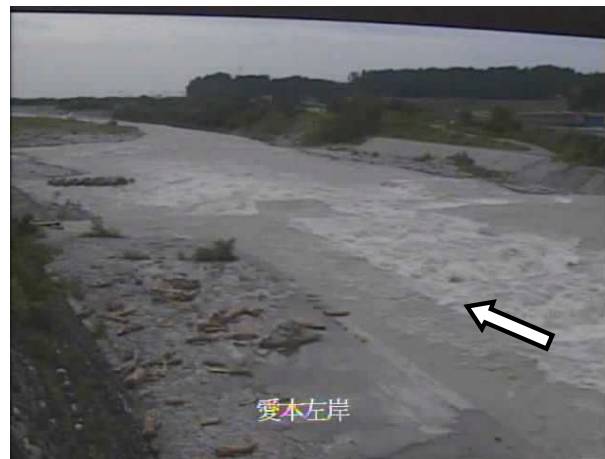
愛本橋下流（上流左岸より望む） 6/28 15:00
