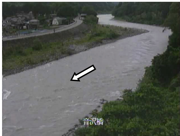
音沢橋（下流より望む） 6/28 10:00
