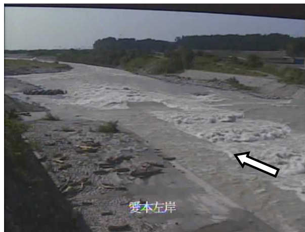
愛本橋下流（上流左岸より望む） 6/29 16:00
