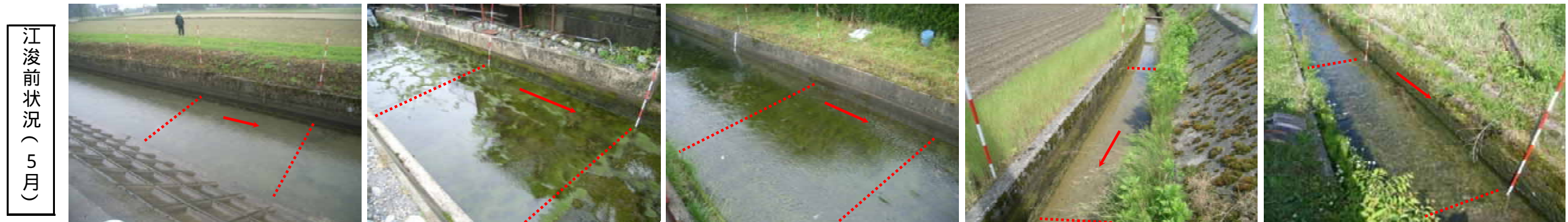
赤破線の5m区間が調査対象区間である。
