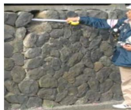
擁壁の危険度調査
