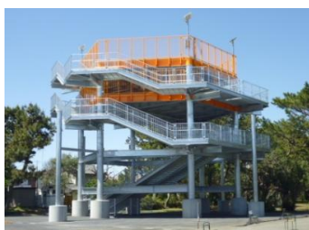
津波避難タワー
