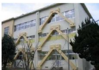
耐震ブレースによる建物の耐震化
