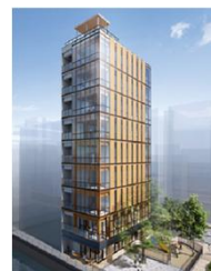
木・鉄骨造の9階建て事務所
