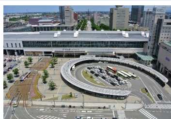
富山駅付近連続立体交差事業
