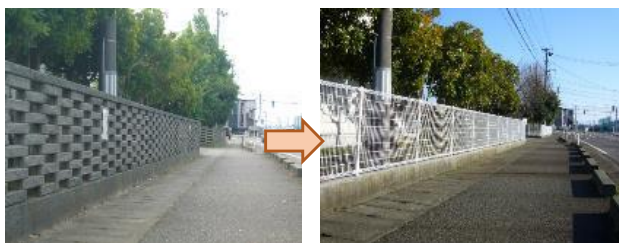
危険なブロック塀の除却・フェンスの設置
