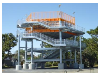
津波避難タワー
