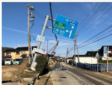
令和6年能登半島地震液状化被災状況 (石川県内灘町)
