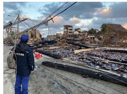
令和6年能登半島地震被災状況（石川県輪島市）
