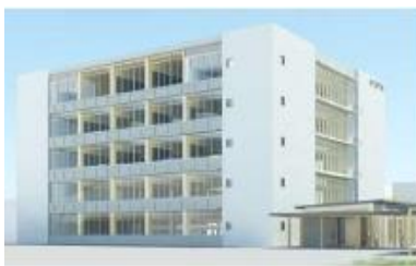
木質耐火部材を用いた大規模庁舎
