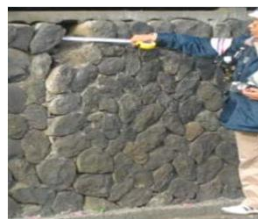
擁壁の危険度調査
