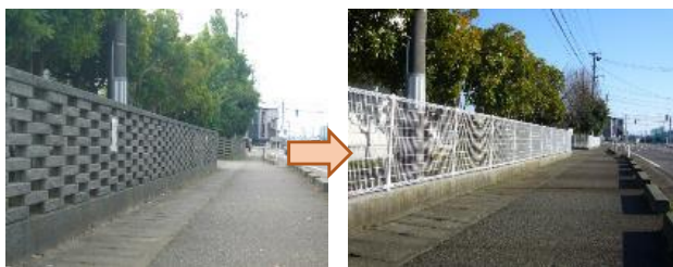
危険なブロック塀の除却・フェンスの設置
