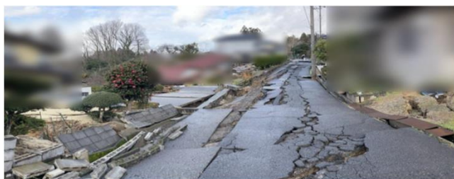
令和6年能登半島地震被災状況 (石川県七尾市)
