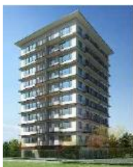
CLTを用いた10階建て共同住宅
