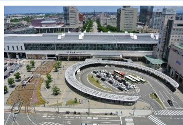
富山駅付近連続立体交差事業
