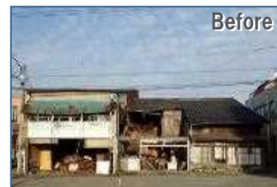
空き家の除却
