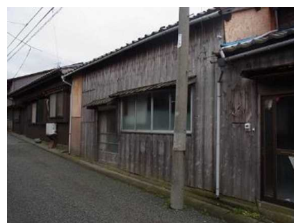
旧深見家住宅改修
