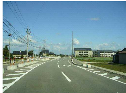
▲完成した町道前沢中央線
