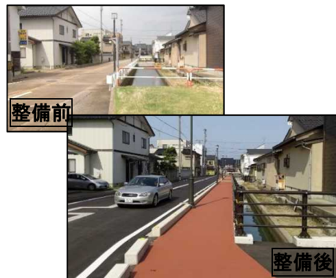
▲準用河川の上部空間を利用した歩道整備
