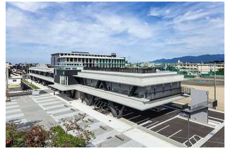
▲ 整備後の地域交流広場及び施設
