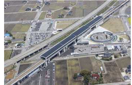
▲ 整備後の新幹線新駅周辺
