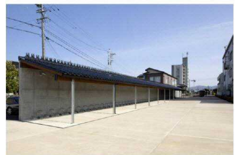
▲ 駅北広場自転車駐車場
