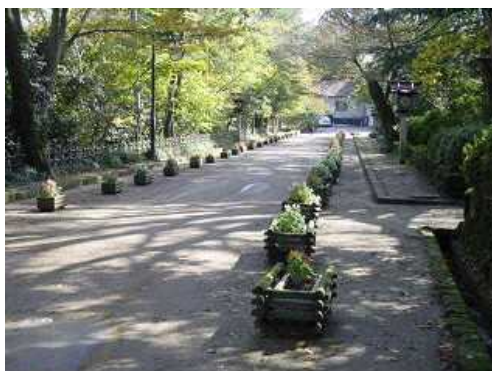
▲ 路面に改良が必要な整備前の古城公園の園路
