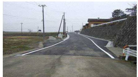
▲整備後（道路事業：村道弥彦上泉線）
