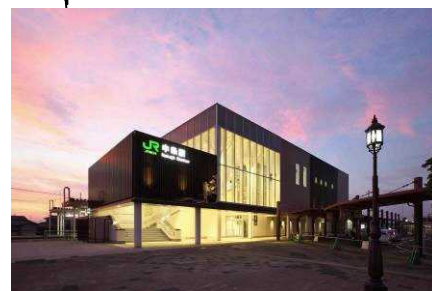
中条駅舎高架化状況
