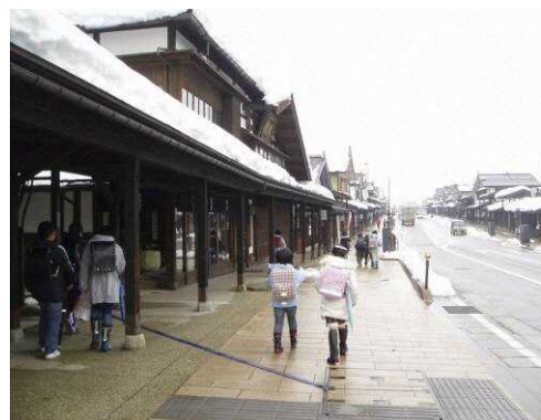
景観に配慮した新しい町並み
