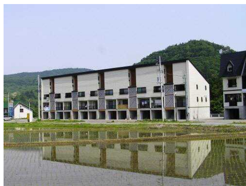
▲ 10世帯が暮らす公営住宅
