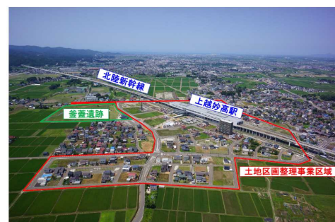
▲北陸新幹線上越妙高駅建設 完了
