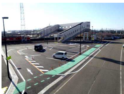
▲ 整備後の北口広場
