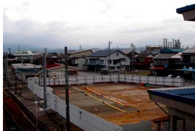
▲ 北口広場の現状
