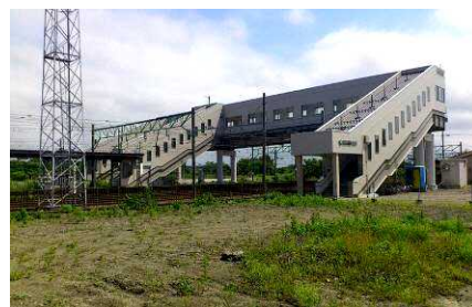
▲ 駅北口と南口を結ぶ自由通路
