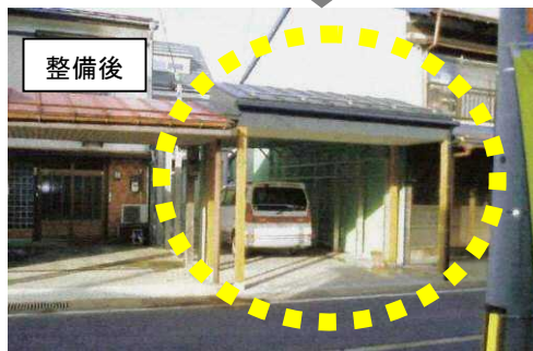
▲雁木整備事業補助金の活用事例
