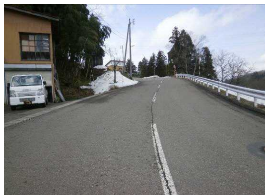
整備されたアクセス道路（改良後）
