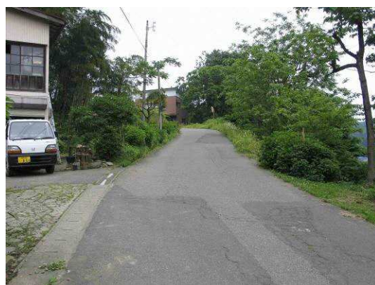
狭隘なアクセス道路（改良前）
