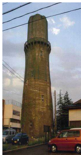
▲旧配水塔整備事業
