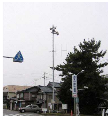
▲屋外拡張子局設置及び 既設設備のデジタル化
