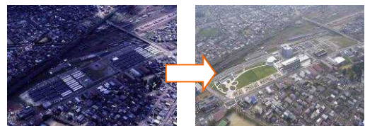
▲ 地区全景 整備前(仮設住宅) ⇒ 整備後
