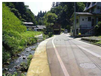
▲完了後（浦瀬町地内）
