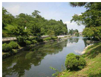
▲完了後（悠久山公園）
