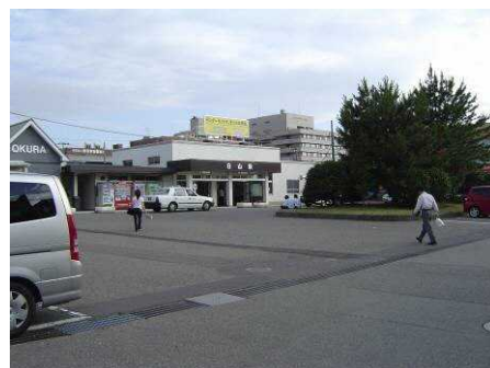
整備前の JR 白山駅北口駅前広場
