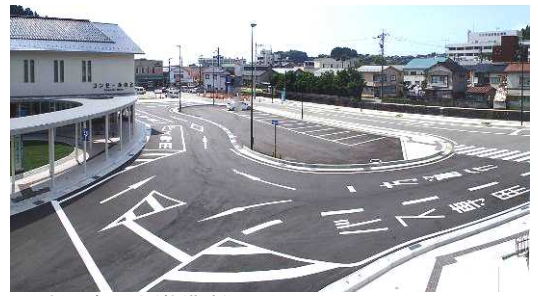
◆宇出津駅跡(整備後)
