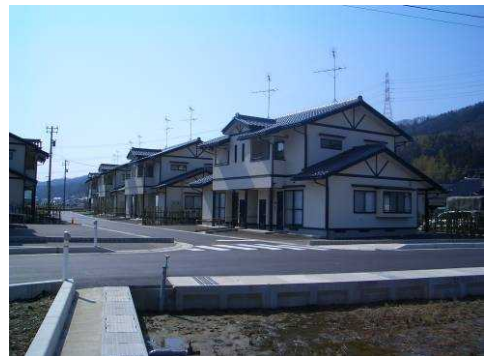
▲定住促進を目的とした公営住宅
