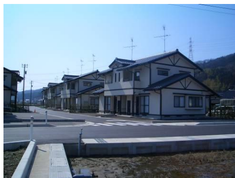
▲定住促進を目的とした公営住宅
