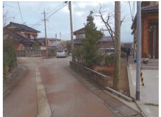
狭隘な生活道路の整備（整備前）
