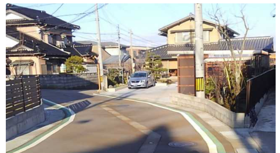
狭隘な生活道路の整備（整備後）
