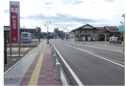
▲ 整備が完了した能美東西連絡道路
