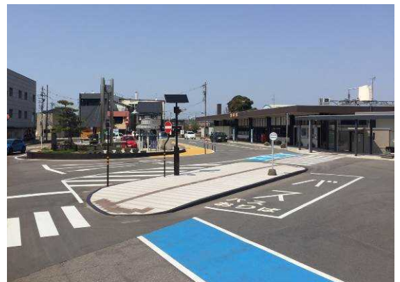
羽咋駅もてなし空間整備
