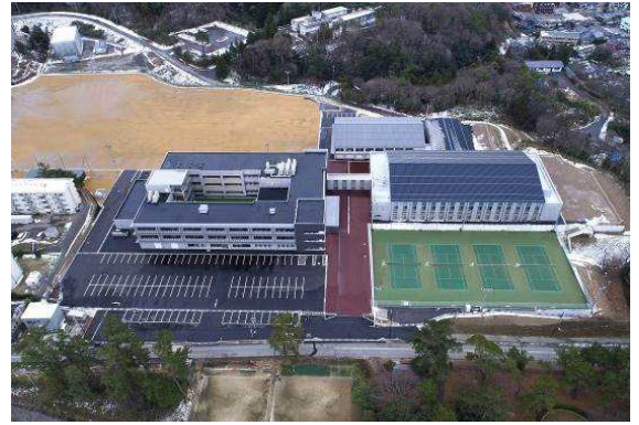
【中心拠点誘導施設として整備した輪島中学校】
