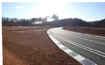
【臨空産業団地（道路） 整備後】
