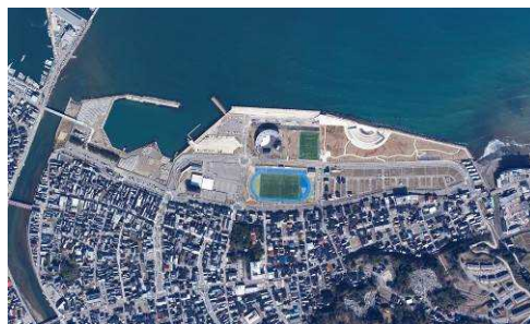
▲輪島地区の整備が集中するマリタウン【整備後】
