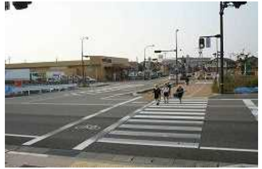
金沢外環状道路海側幹線
