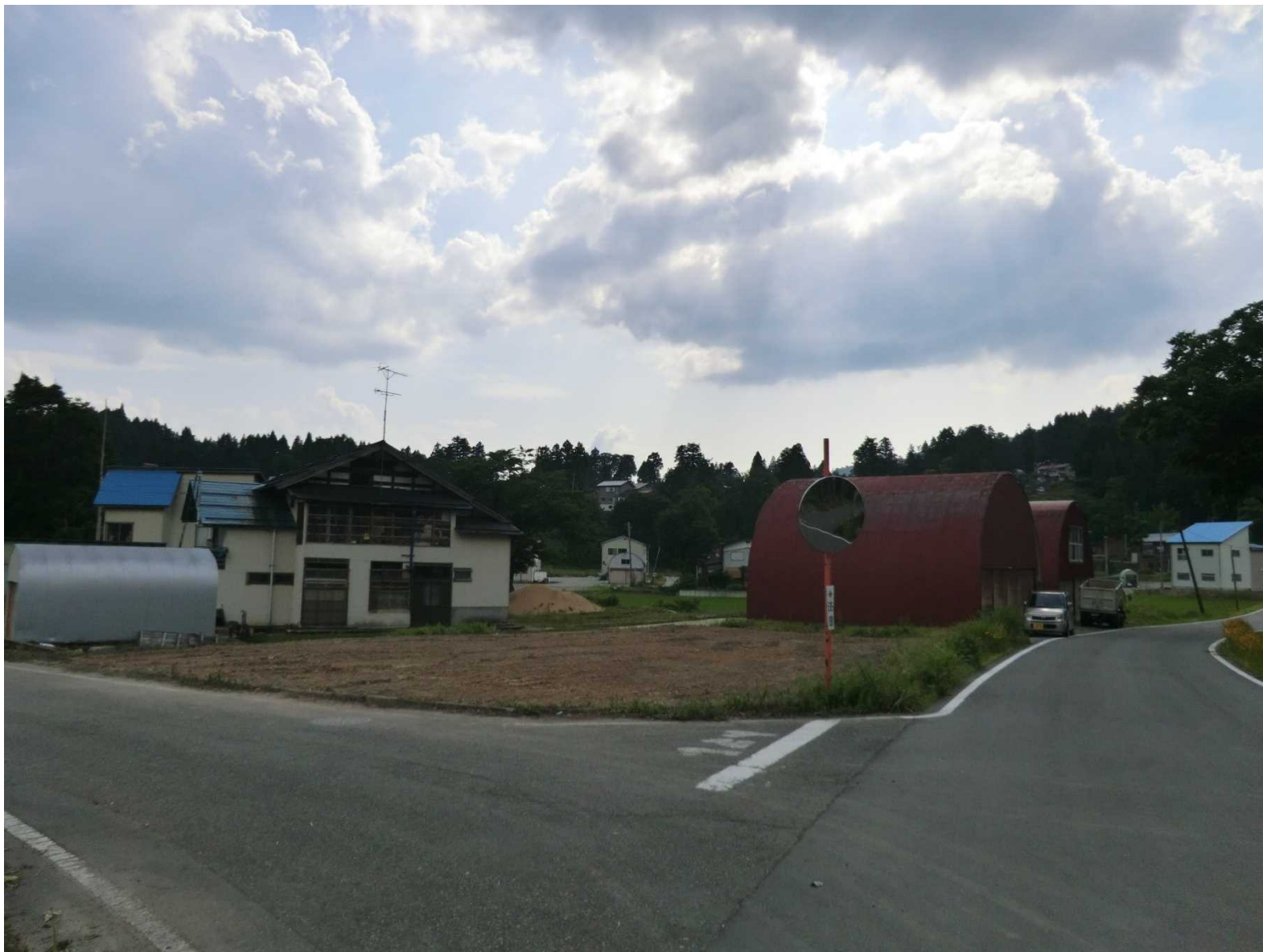
山古志地域の空き家（助言・指導後に解体）
