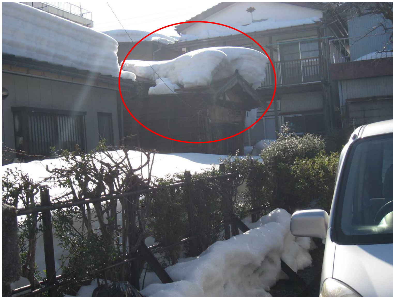
隣家から倒壊するとの通報あり。(長岡地域)
