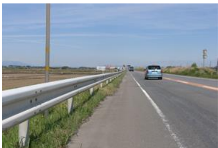
【防護柵の設置】
