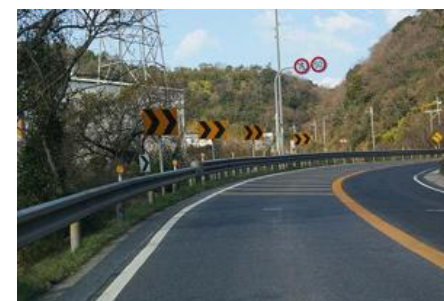
【視線誘導標の設置】
