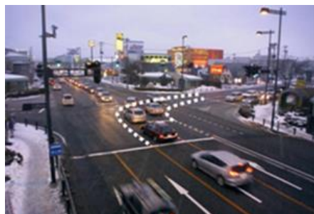
【導流標示の設置】
