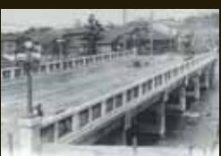
大正8年(1919年)に完成した犀川大橋は橋脚の多い鉄筋コンクリート橋で、とてもかちりととしたのであった。この橋は、それまで片町にまでいた市内電車をさらに寺町台地にまで長くするため、それ以前の木橋を取り壊し、一年余りかけて完成したものであった。
