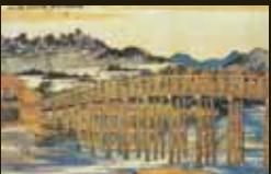
文政3年(1594年) 加賀藩主・前田利家により犀川大橋は架設された。延宝金沢図(県立図書館蔵)によれば、当時の木橋の長さは40間、幅3間であり、城下隨の大きさであったという。木造の大橋は、洪水はらんのたびに流れられたり損傷をうけた。緊急の場合引き農業を妨げていたため、農民の請願によって秋穫の後修造された。また、大雨で水没されるたびにかけられた木橋として舟橋を対にして多く、橋の下間に舟を浮かべ、頭を連ねた木橋やスカグリ(木橋)、木の舟橋に応じて船橋と名づけられた。
