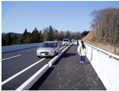
③国道 249 号大谷道路
