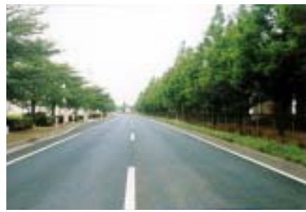
沿道の緑化や低騒音舗装などによる生活環境の保全 （国道 8 号 金沢市南新保地内）
