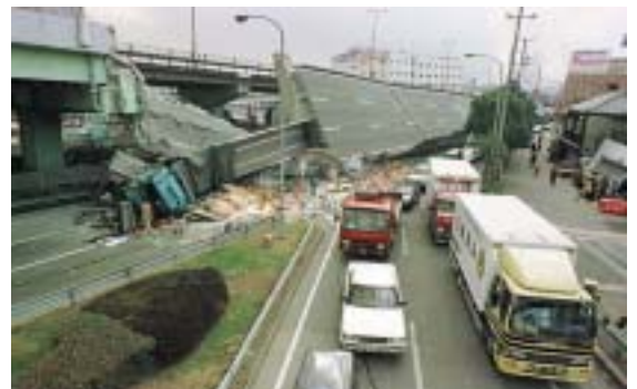
阪神淡路大震災の状況
