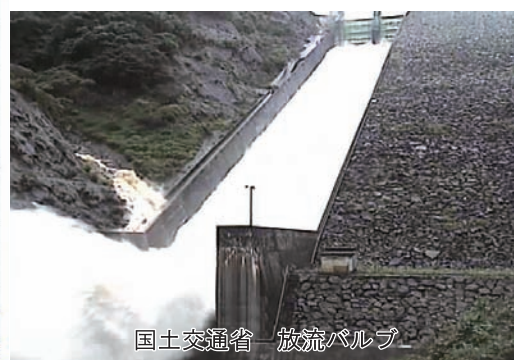
国土交通省 放流バルブ 手取川ダム放流状況 (7月17日 5:00)
